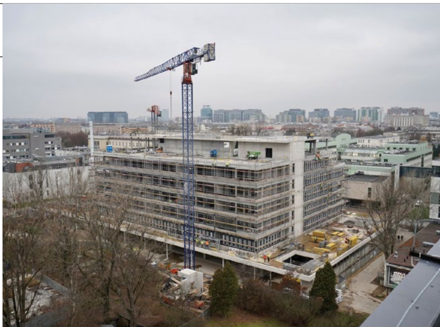
Konstrukcja całości budynku, który będzie miał łącznie osiem kondygnacji
