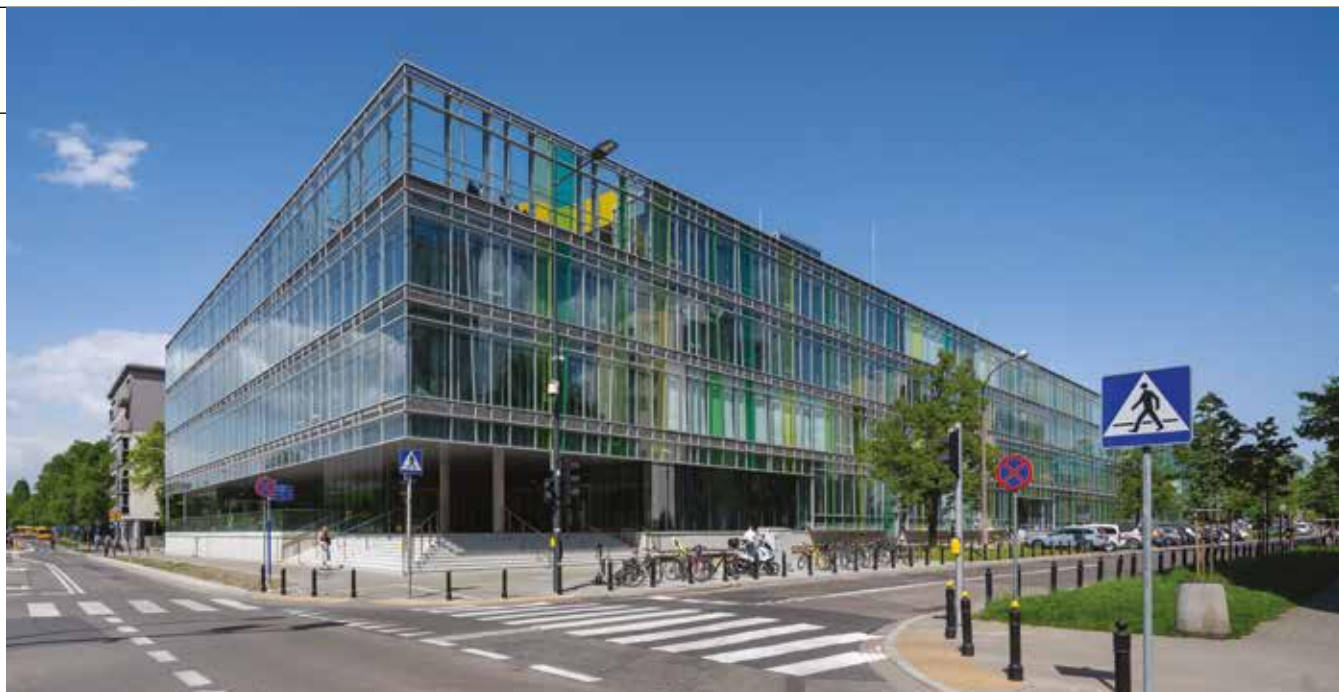
Zdjęcia: Budynek UW przy ul. Dobrej 55.
