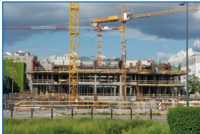
^ Budowa II etapu budynku przy ul. Dobrej 55, czerwiec 2020 r.
