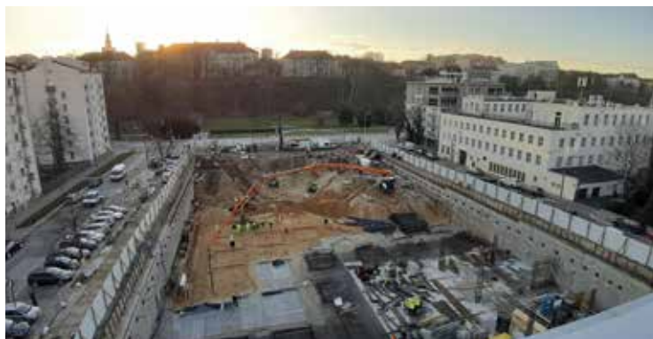
Teren budowy II etapu gmachu przy ul. Dobrej 55. Widok z dachu budynku wybudowanego w ramach I etapu.
