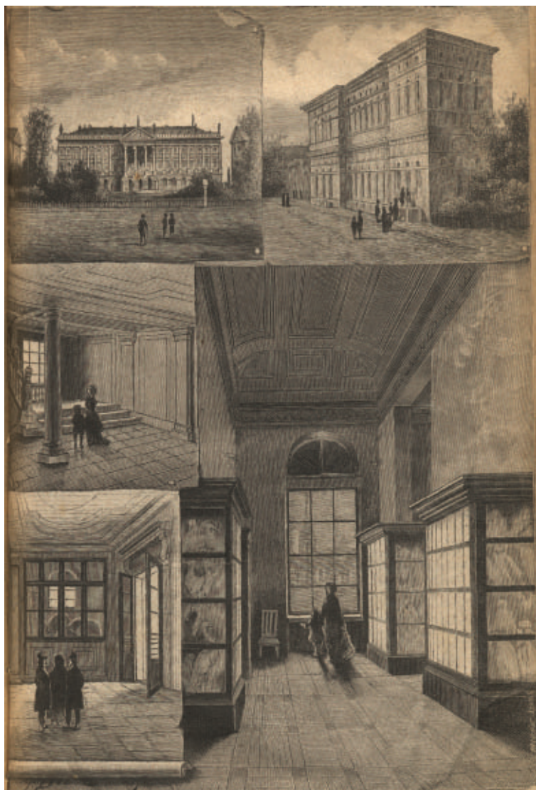
W prawym górnym rogu budynek Instytutu Historycznego, poniżej wnętrza gmachu, 1882 r., APW
