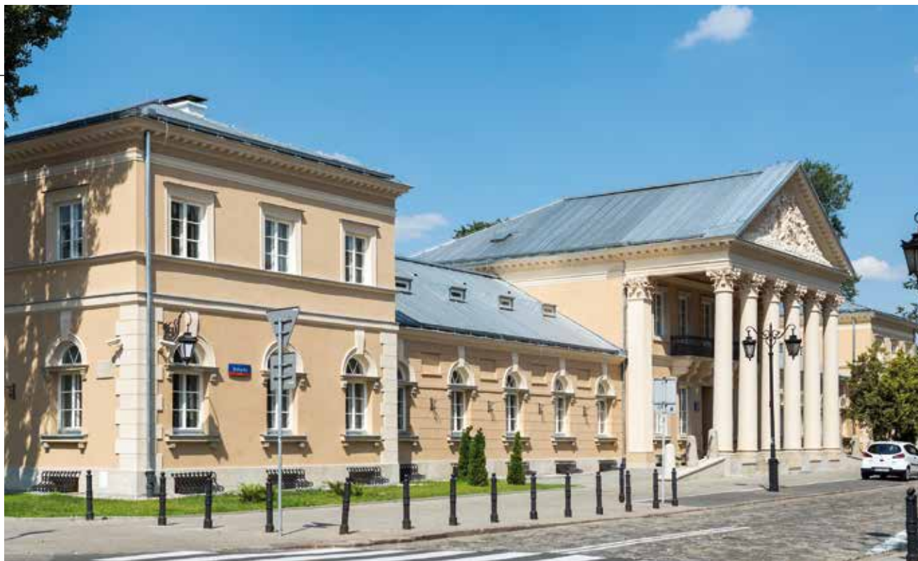
Łaźnie Teodozji Majewskiej po renowacji.
